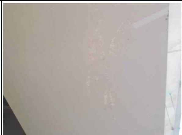
위 치 Steel Box Girder(외부, S10, G6)
