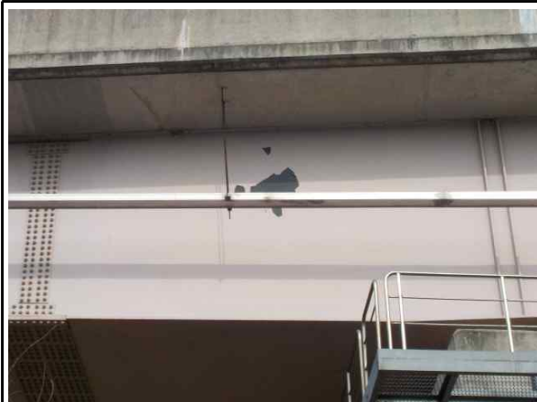
위 치 Steel Box Girder(외부, S1, G6)
