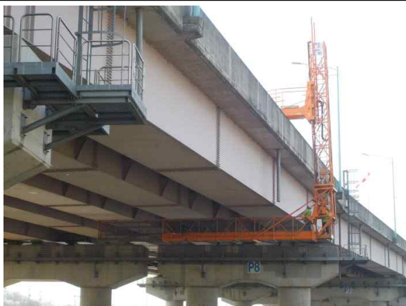
사진설명 교량점검차를 이용한 근접조사
