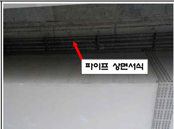
위 치 Steel Box Girder(외부, S10, G4)
