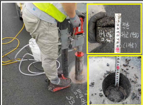
사진설명 교면포장 방수층확인(코어채취)
