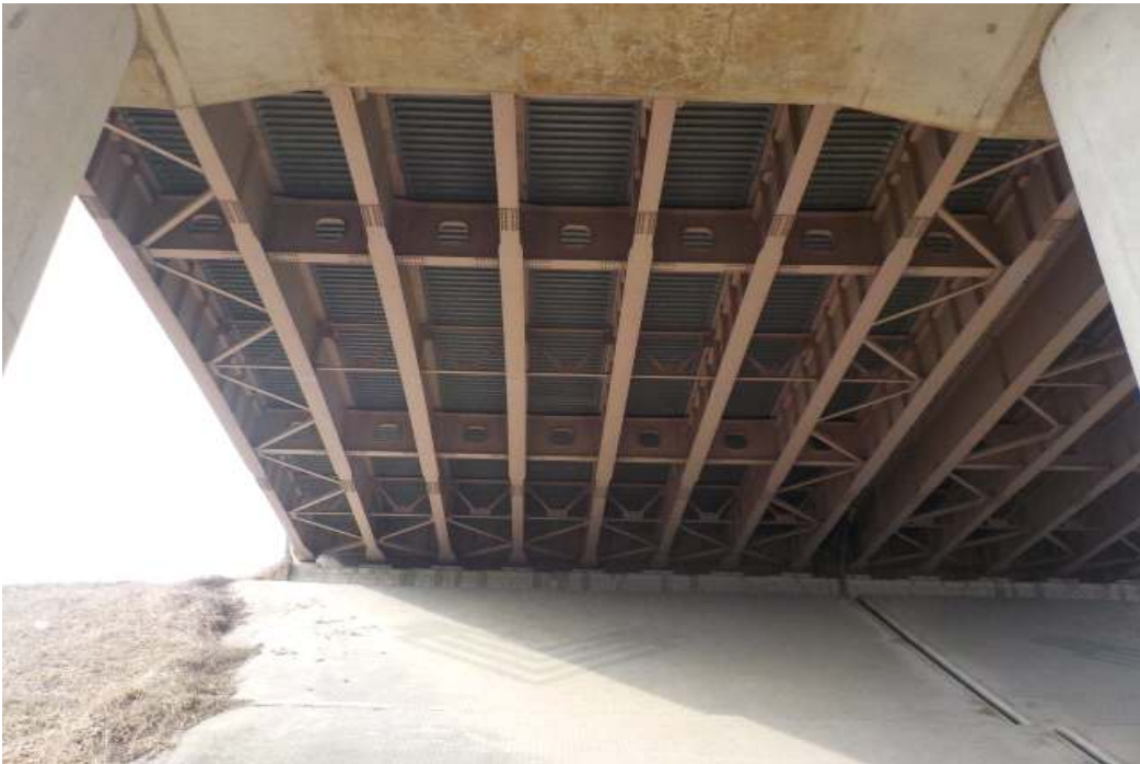
거더외부 전경(Steel Plate Girder)
