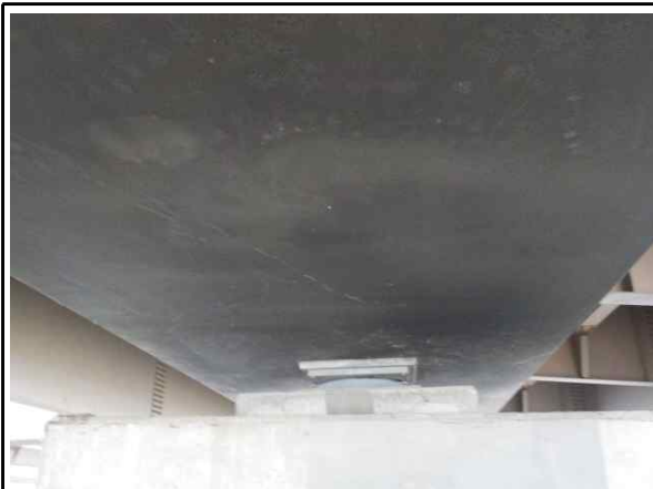
위 치 Steel Box Girder(외부, S10, G4)
