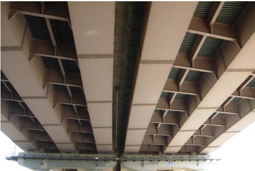
거더외부 전경(Steel Box Girder)
