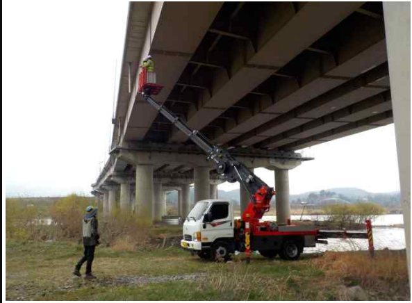
사진설명 고소작업차를 이용한 근접조사
